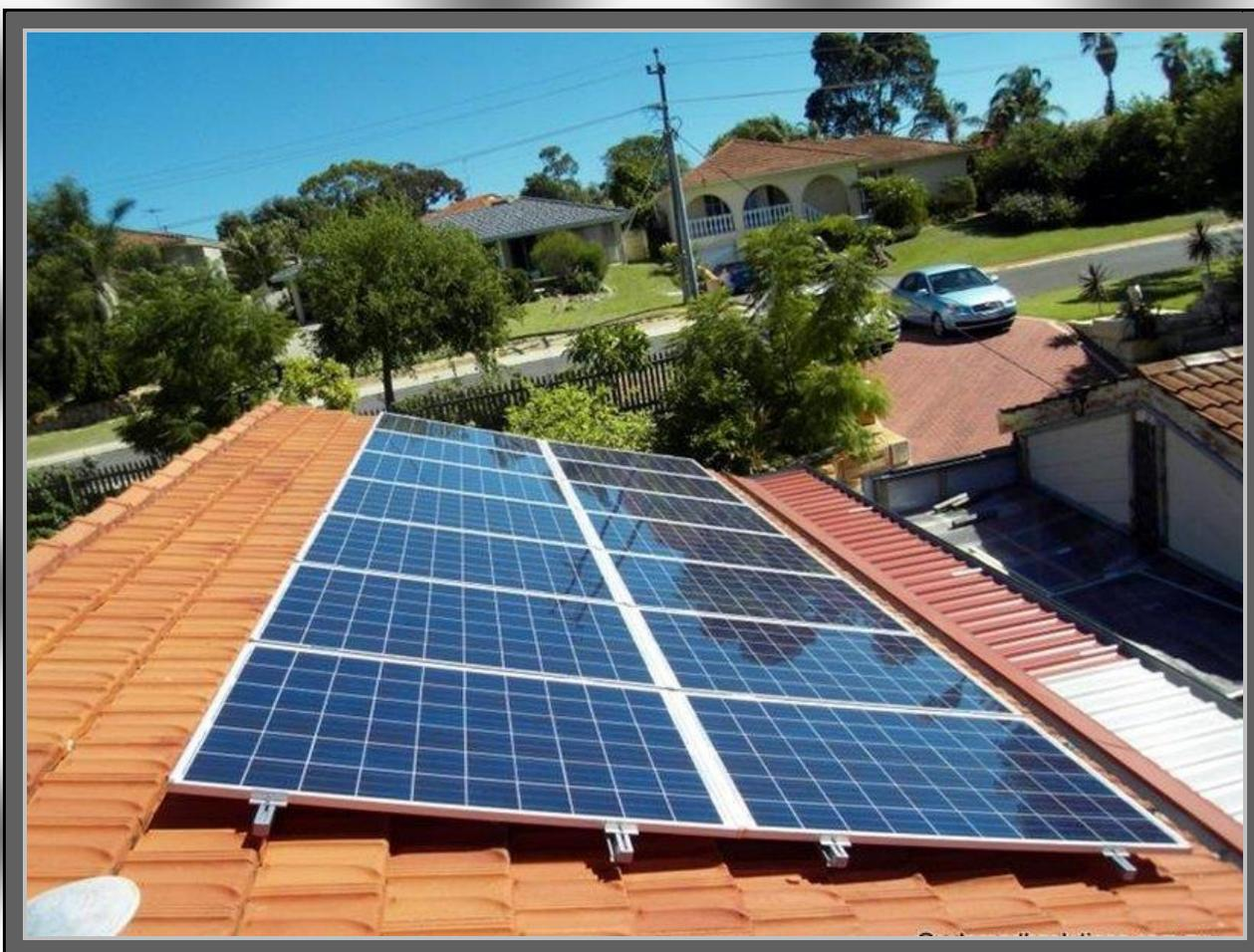
Além do local de instalação, é necessário avaliar qual a estrutura de fixação ideal para o sistema, a partir de uma análise do telhado. Em edifícios é comum encontrarmos lajes ou telhas de fibrocimento, mas prédios mais antigos podem ter coberturas de telha de cerâmica. Para cada uma dessas
